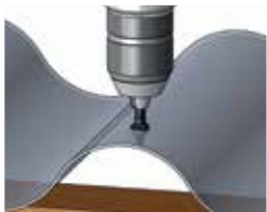
1. Vorbohren der Profiltafel mit Stufenbohrer 4-10 mm
